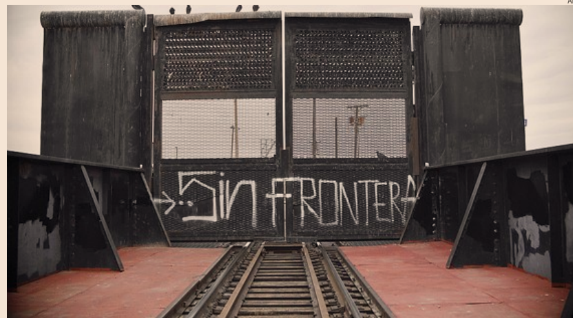
Senza frontiere. Il posto di confine ferroviario tra Ciudad Juarez (Messico) ed El Paso Texas
